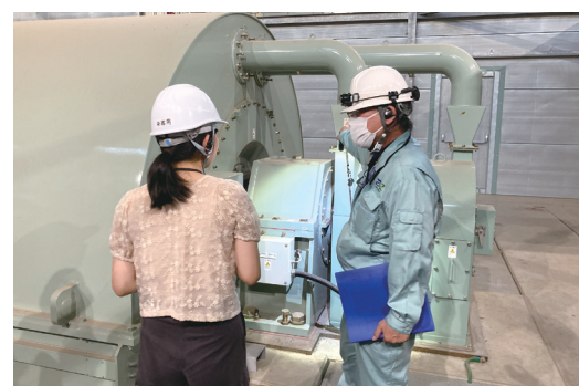
福島いわきバイオマス発電所を訪れ、再生可能エネルギーの現場を見学。
